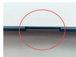
Afbeelding beluchting dmv rubberdichting onderbreking.
