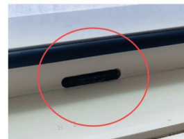
Afbeelding ontwatering sleuf binnenzijde.
