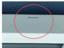
Afbeelding ontwatering sleuf buitenzijde.
